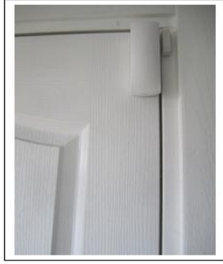
Resim 2.20: Kablosuz kapı kontağının kapı ve pencerelere montajı ( kapı kapalı– açık )
