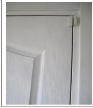
Resim 2.19: Kablolu kapı kontağının kapı ve pencerelere montajı (kapı kapalı – açık )
