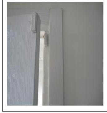
Resim 2.19: Kablolu kapı kontağının kapı ve pencerelere montajı (kapı kapalı – açık )
