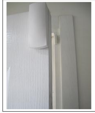
Resim 2.20: Kablosuz kapı kontağının kapı ve pencerelere montajı ( kapı kapalı– açık )
