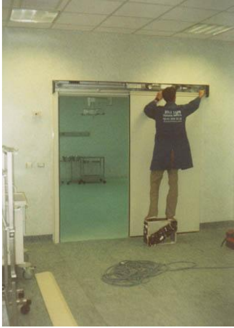
Resim 1.21: Kapı sürgü dişli kasağı montajı
