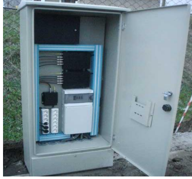
Resim 3.17: Kamera sisteminde kullanılan fiber optik sonlandırma panosu
