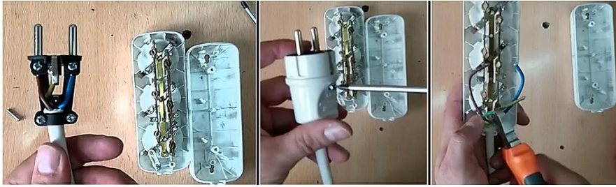
Fotoğraf 2.7: Fiş ve priz bağlantısının yapılması-1
