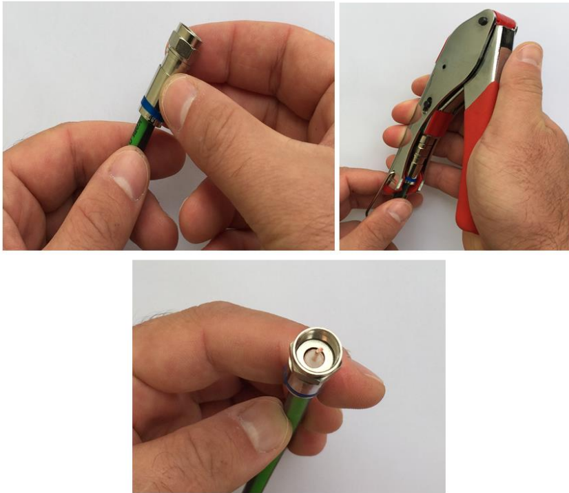
Fotoğraf 2.10: Anten kablosuna F konnektör çakılması-2
