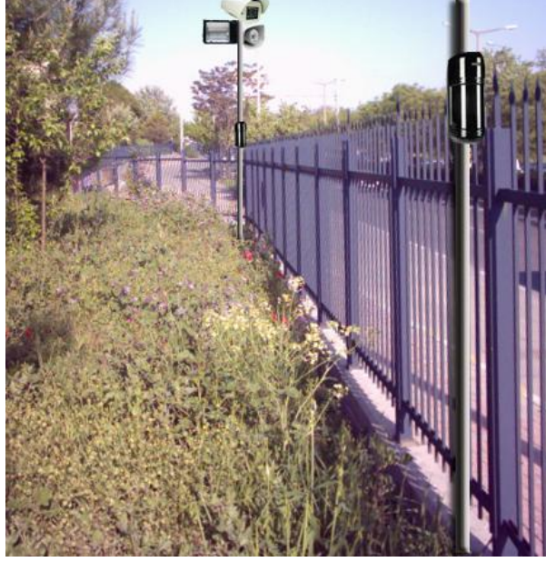
Şekil 1.72: Örnek bir direğe beam detektör montajı
