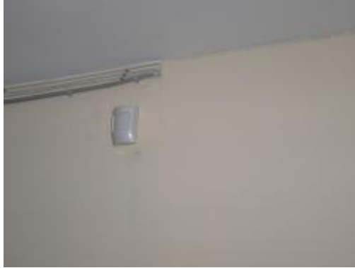
Şekil 1.35: Duvara monte bir pir detektörü ve tarama alanı (b)
